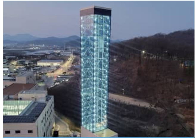
TS 첨단자동차검사연구센터 주차타워(컬러BIPV모듈) 10kW
