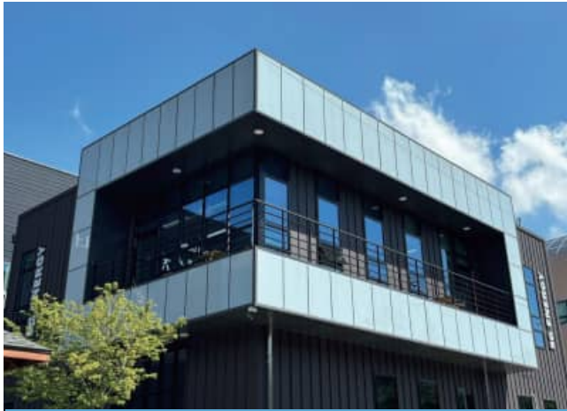
(주)에스지에너지 본관동 화이트BIPV(컬러BIPV) 총용량 : 6kW
